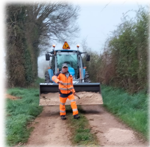
Bouchage des nids de poule dans les chemins blancs
