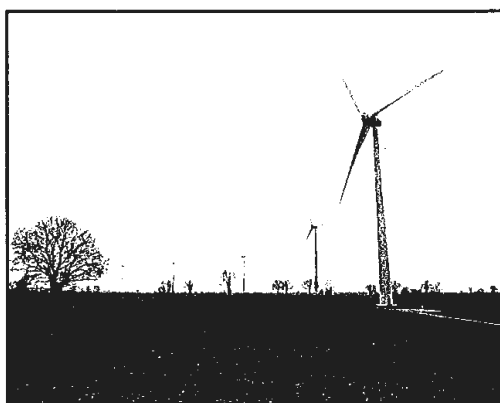
Parc éolien, Collection CREN Melleran – Lorigné – Hanc – La Chapelle-Pouilloux
